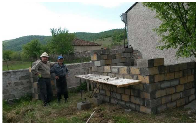
Bau der Toiletten
