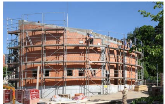
Der Rohbau in Schönheide
