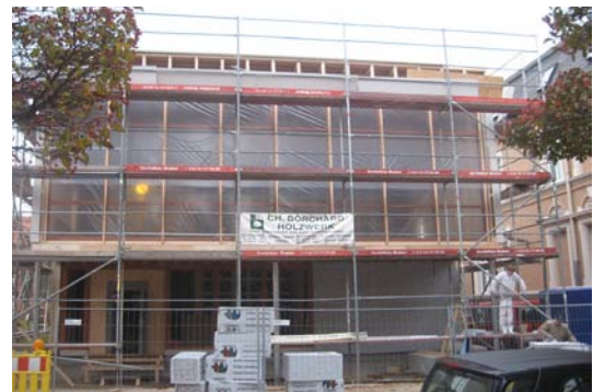
Die eingerüstete Kirche in Braunschweig
